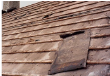
Zborcení konstrukce budovy působením hub a plísní
